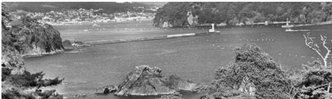
Рис. 1. Волнолом в устье бухты Офунато на северо-западе Японии, построенный для защиты от цунами.
