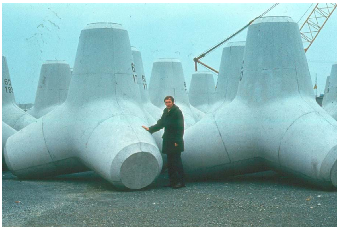
Рис.2. Железобетонные «ежи» для защиты морского берега от размыва.
