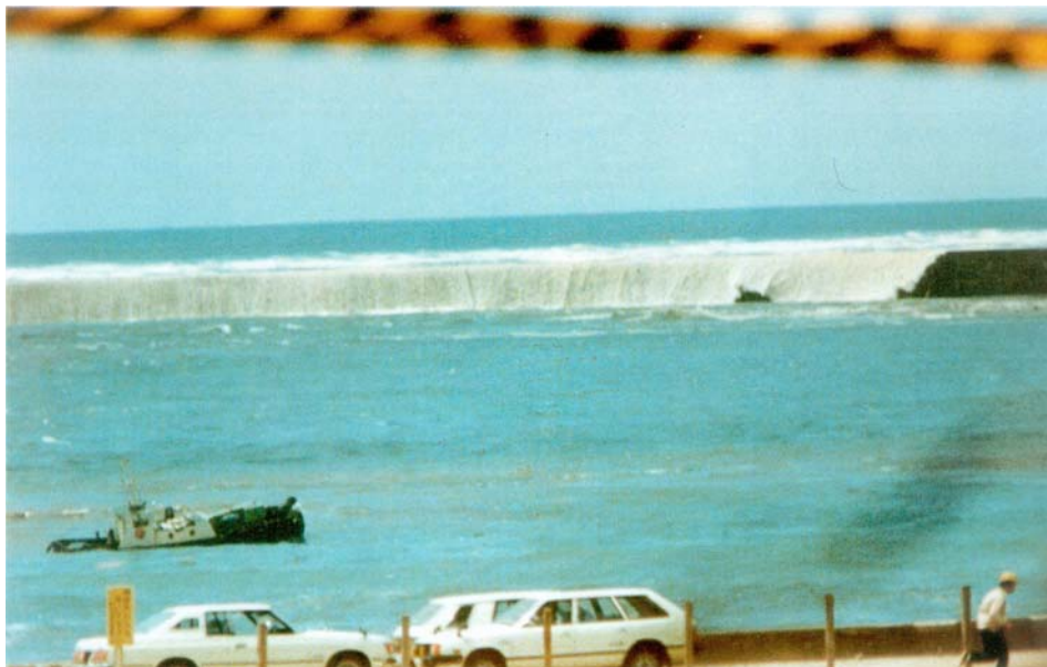
Рис. 4. Перелив волны цунами через шестиметровую стену в порту г. Носиро (Япония).
